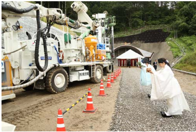
▲ 施工機械へのお祓い
