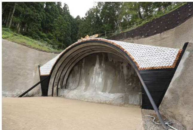
▲ 庄司渚トンネル坑口
